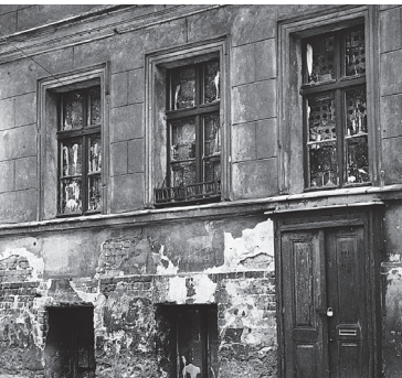
B 384: Vermauertes Erdgeschoss, 23. August 1961
